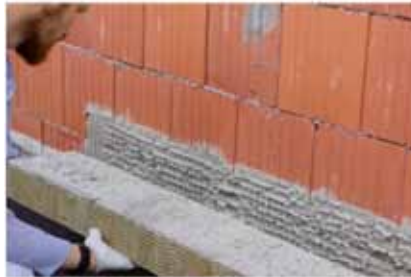
Vollflächige Verklebung im Floating-Buttering-Verfahren
