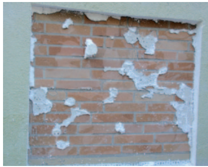
Öffnung der Fassade zur Prüfung und Dokumentation der Verklebung des Bestands-WDVS
