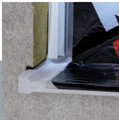
Ausklinken des Dämmstoffs.
