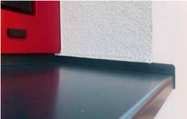
Abb. 6: Beispiel für eine fachgerechte Ausbildung mit nachträglich eingeschobener Metall-Fensterbank. Das „Gewerke- loch“ bzw. die „Gewerkelücke“ ist dauerhaft geschlossen.
