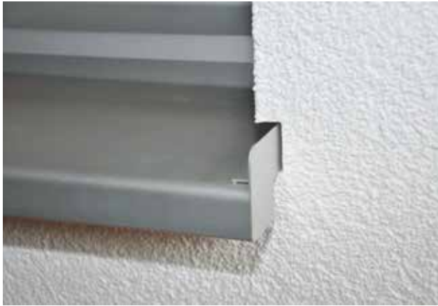
Abb. 13: Beispielhafter Einbau einer Einschublösung mit Metall-Fensterbank
