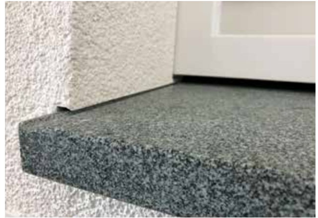
Abb. 14: Beispielhafter Einbau einer Einschublösung mit Steinfensterbank
