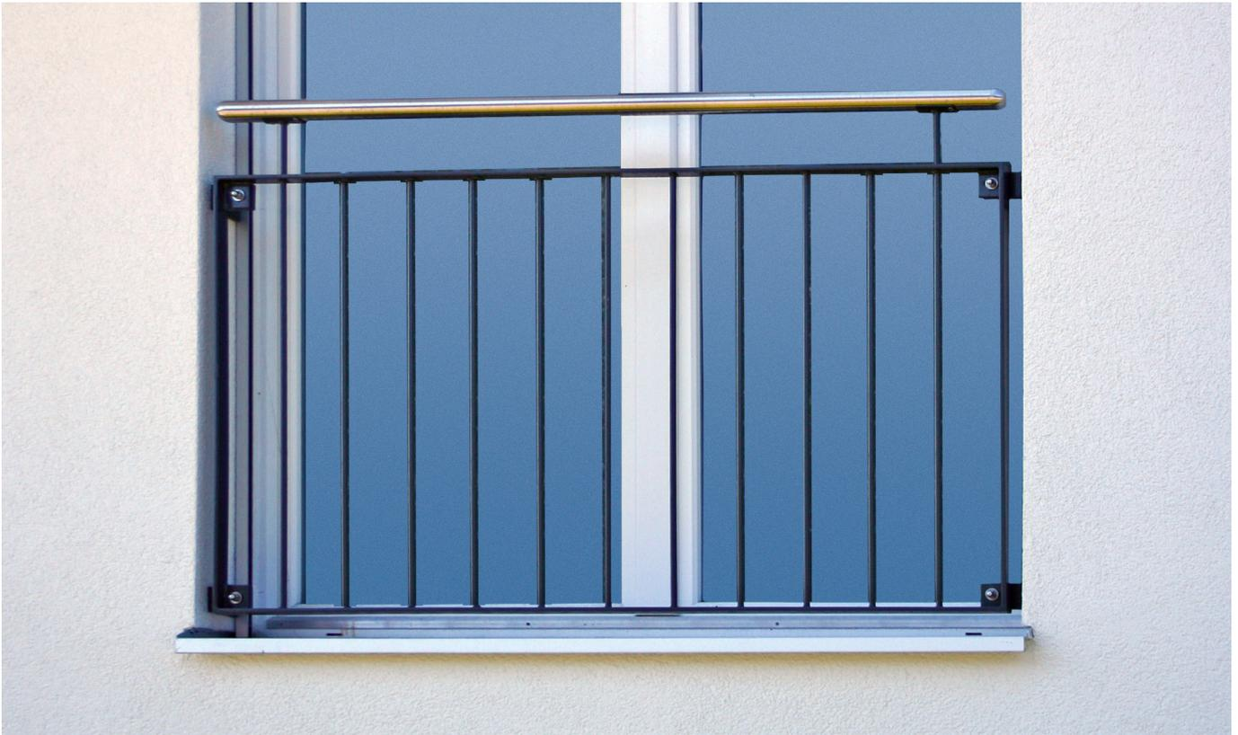
Bodentiefe Fenster ermöglichen helle und lichtdurchflutete Wohnräume. Lassen sich die Fenster öffnen, muss ein Geländer als Absturzsicherung montiert werden.
