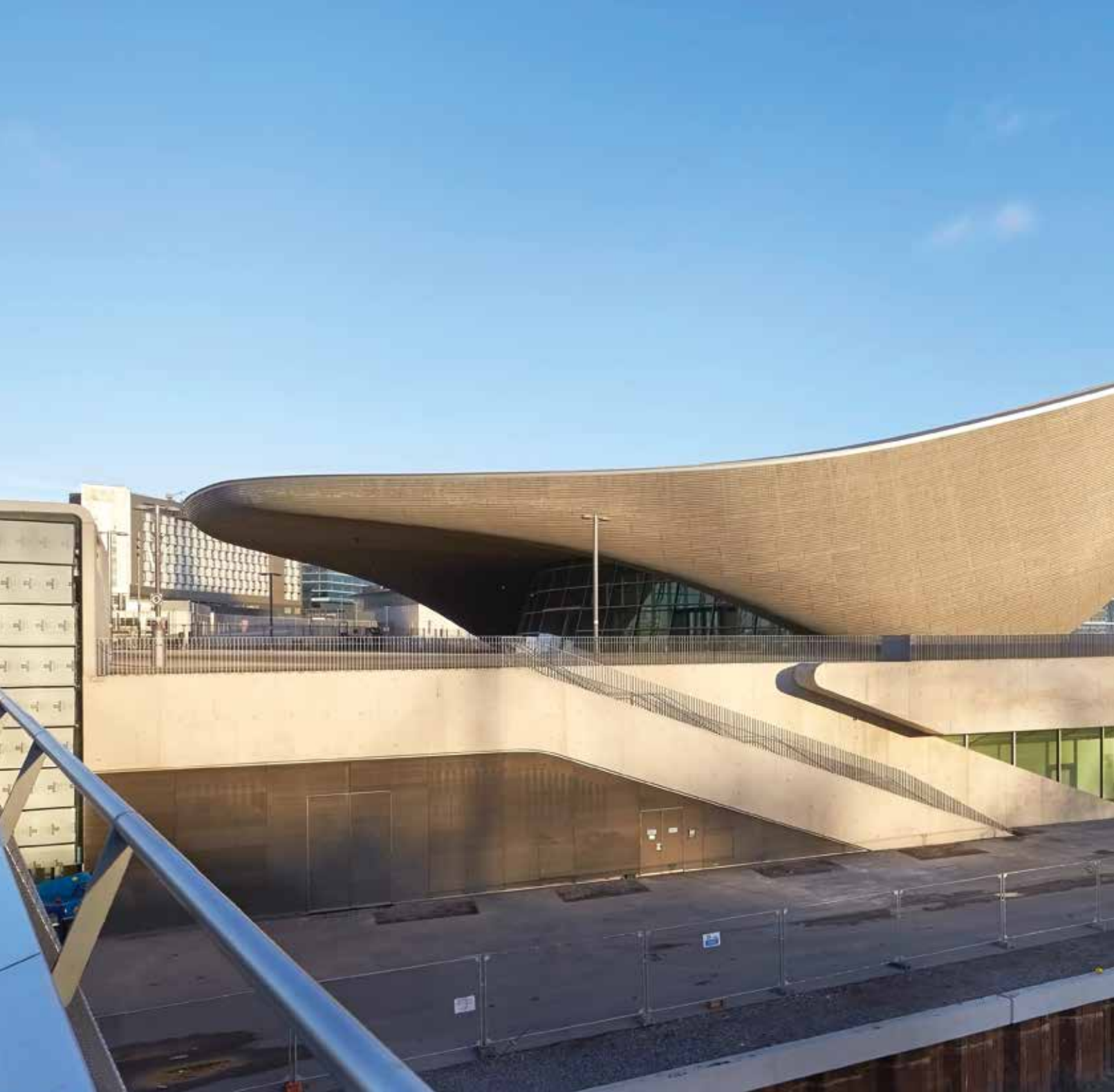
Welle im Post-Olympia-Modus. Nach dem Rückbau der Tribünen kommt die fließende, geschwungene Form des Dachs voll zur Geltung.
