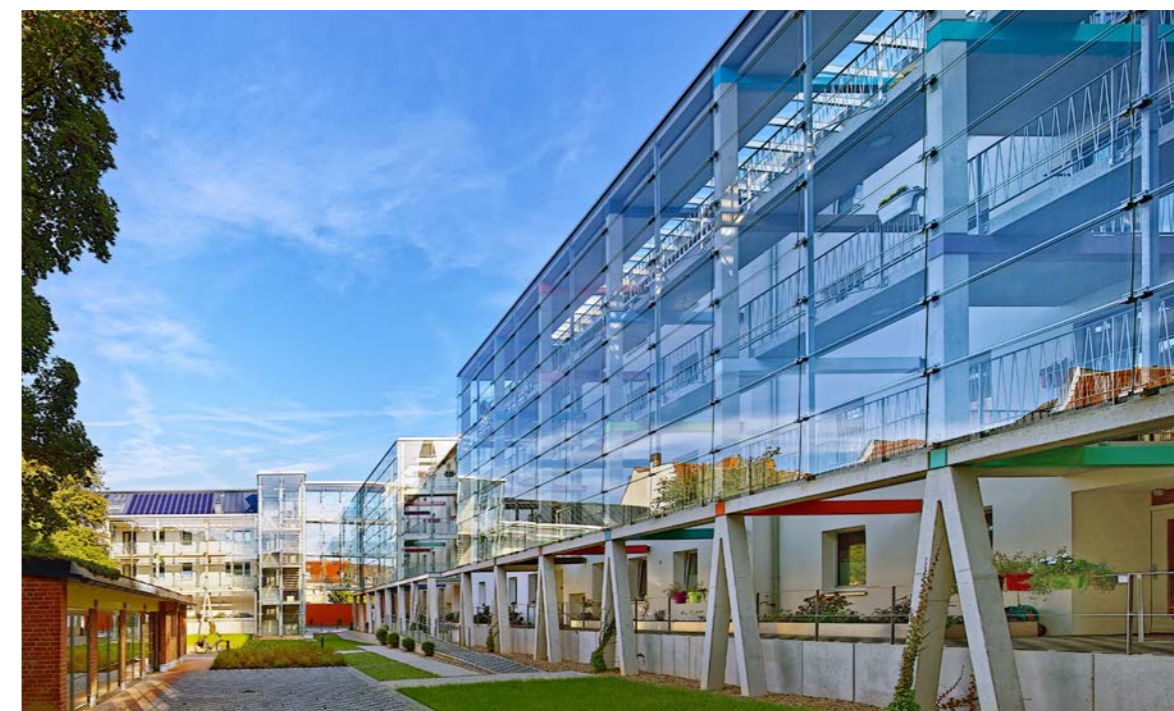
Sanierung mit Mehrwert: Wohnwege vor der Fassade einer Siedlung in Bremerhaven schaffen Begegnung, Farben dienen der Orientierung.
