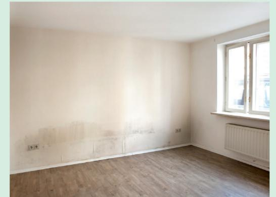
Sichtbarer Schimmel nach Wasserschaden ist häufig nur die Spitze des Eisberges. Vor einer Sanierung ist daher eine mikrobiologische Bestandsaufnahme ratsam. Auf dieser Grundlage kann ein passendes Schimmelsanierungskonzept erstellt und umgesetzt werden. Von der Verwendung von Fungiziden in Innenräumen raten Experten generell ab.
