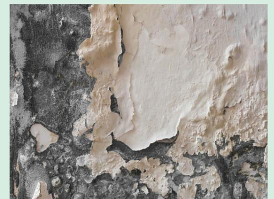
Durch erhöhte Feuchtwerte im Mauerwerk erdberührter Bauteile entstehen unterschiedliche Schadensbilder: Ausblühungen, Abplatzen von Anstrichen und Putzen, Absanden von Putzen, Gefügezerstörung von Mauerwerk aber auch Korrosionsschäden an einbindenden Stahlträgern.
