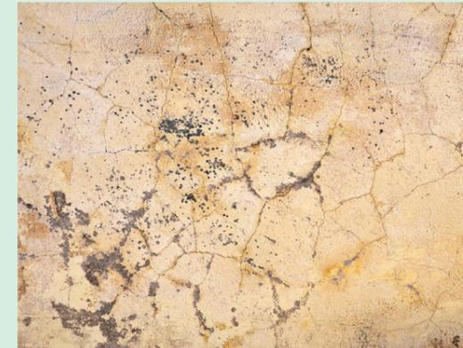
Werden nach dem Abpumpen des Wassers Risse und/oder Abplatzungen an tragenden sowie nicht tragenden Bauteilen sichtbar, sollte eine Begutachtung durch einen Tragwerksplaner erfolgen. Hat nur der Putz Schaden genommen, die Struktur ist jedoch weiterhin tragfähig, lässt sich die Wand in vielen Fällen mit geeignetem Material überputzen.
