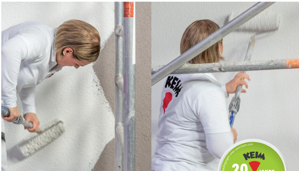
1. Material satt auftragen. 2. Mit Material in geraden Bahnen nachrollen. 3. Fertig!
