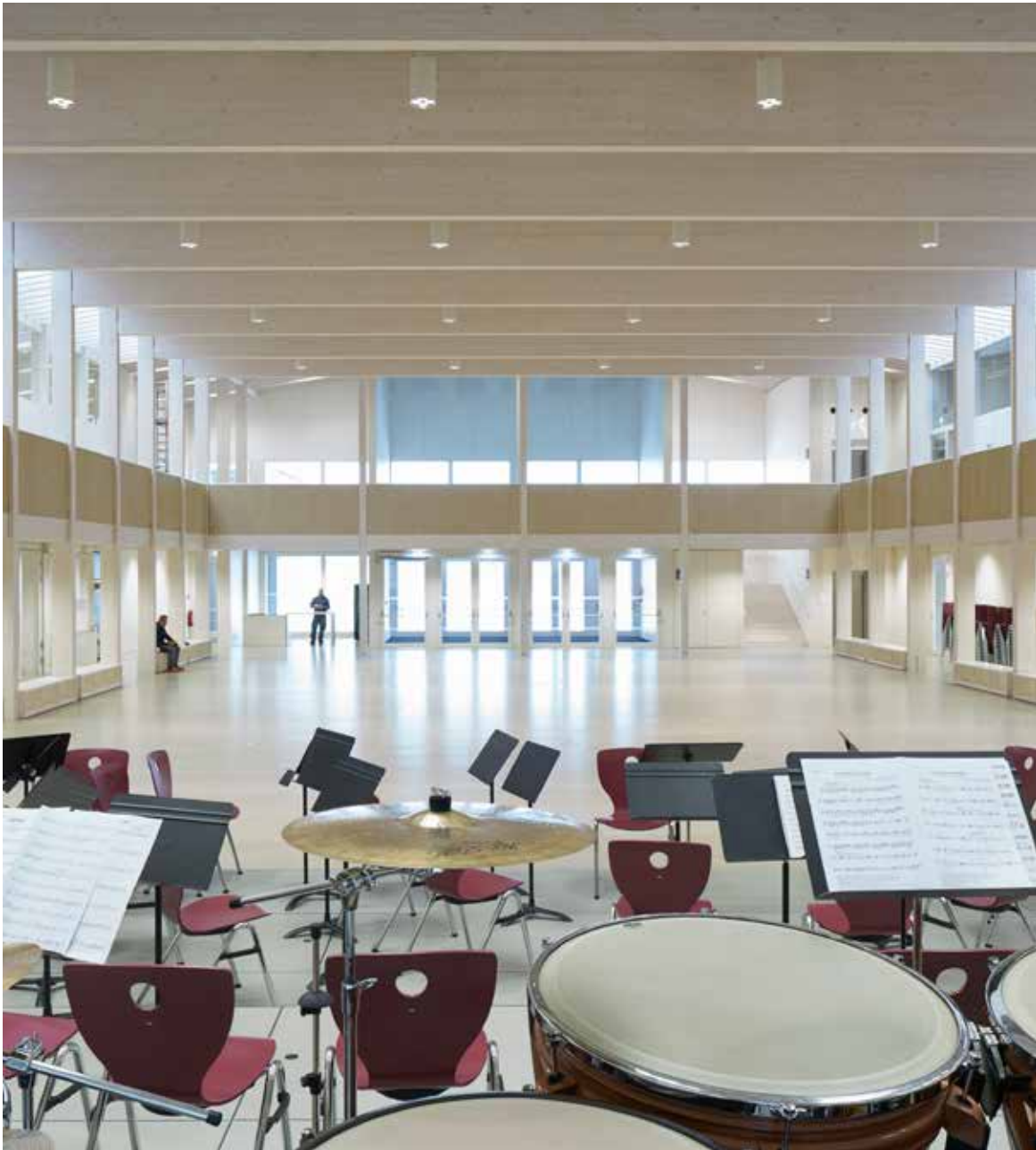
Blick vom geöffneten Musiksaal durch die Aula zum Haupteingang: Auffällig schlanke Stützen tragen das Dach.
