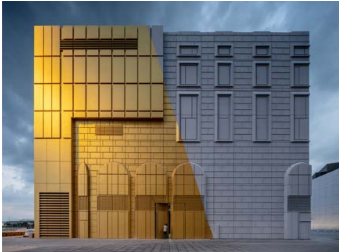
Die Blackbox ist ein „dekorierter Schuppen“ und greift charakteristische Formen der Nebengebäude auf.
