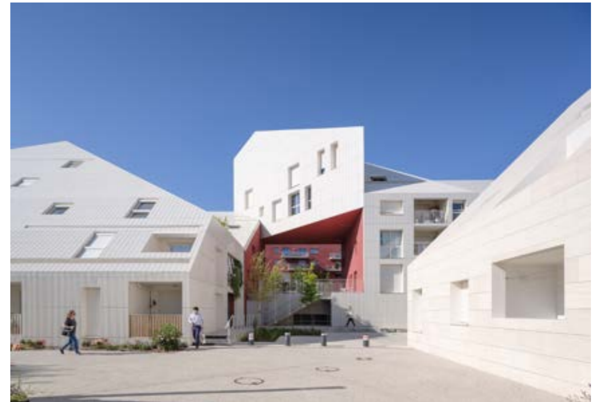
Zur Straße hin überziehen weiße Keramikpaneele Wände und Dächer, zum Innenhof zeigt sich das Gebäude mit einer weinrot verputzten Fassade.
