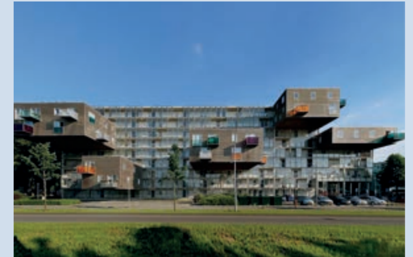
WoZoCo, Amsterdam, 1997 Bei dem Haus für ältere Menschen kragen auf der Nordseite ganze Wohnungen aus. So fällt weniger Schatten auf die Nachbarbauten und das Grundstück wird optimal ausgenutzt, ohne den Boden zu versiegeln.
