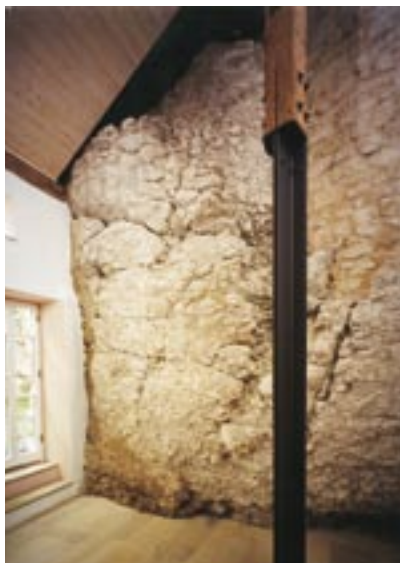
Beim Bau des Hauses wurde der angrenzende Felsen der Einfachheit halber als Wand mit einbezogen.
