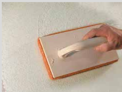
4 Затирка стен грубой пористой теркой
