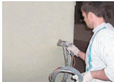
1. Putzauftrag maschinell
