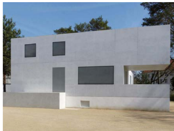
Neue Meisterhäuser in Dessau; Architektur: Bruno Fioretti Marquez Architekten; Lasur: Arbeitsgemeinschaft Betonlasur Berlin
