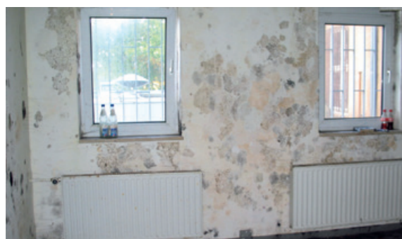
Schimmelpilze kommen in unterschiedlichen Ausprägungen vor. Die Anwesenheit von Feuchte und Organik bestimmt maßgeblich die Befallsintensität.
