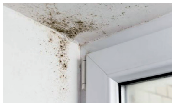
Schimmelpilze kommen in unterschiedlichen Ausprägungen vor. Die Anwesenheit von Feuchte und Organik bestimmt maßgeblich die Befallsintensität.
