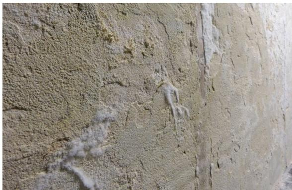
Décollement d'enduit et efflorescence saline marquée
