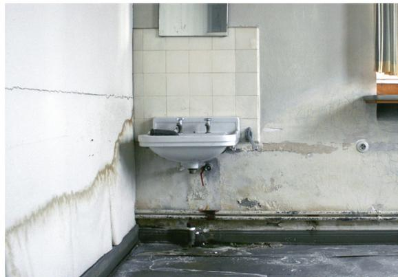
Forte humidité provoquée par un dégât des eaux
