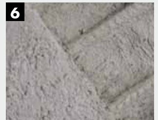
6 De gaten opvullen met minerale KEIM Concretal-Mortel-R in de vochtige hechtbrug. Laagdikten van 0,5 – 5 cm mogelijk. Vanaf ongeveer 2,5 cm in meerdere lagen aanbrengen.
