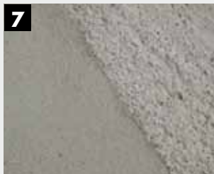
7 Glad maken en structureren met minerale KEIM Concretal-Fijnsachtel op een licht bevochtigde ondergrond. Laagdiktes van 1 - 4 mm mogelijk.
