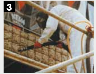
3 De wapening wordt gereinigd door droogstralen met vaste straalmiddelen. Ontroestingsgraad Sa 2 1/2 volgens DIN EN 12944-4
