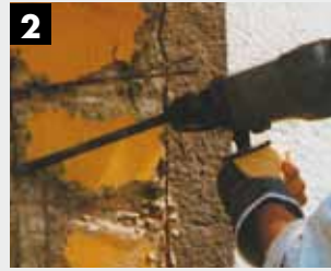
2 De aangetaste wapening wordt vrijgemaakt
