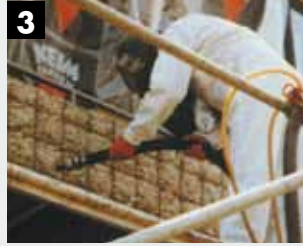
3 De wapening wordt gereinigd door droogstralen met vaste stralmiddelen, ontroestingsgraad Sa 2 1/2 volgens DIN EN 12944-4
