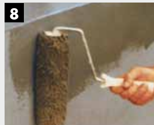
8 Dubbele verflaag met KEIM Concreteon-C. Tweemaal onverdund aanbrengen met een borstel, roller of airless spuit.
