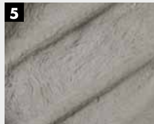
5 De reparatievlakken bevochtigen en vervolgens KEIM Concretal-MKH als hechtbrug intensief inborstelen.
