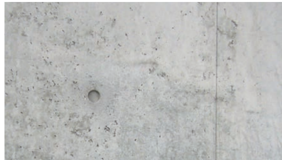
Neubeton mit leichten Flecken
