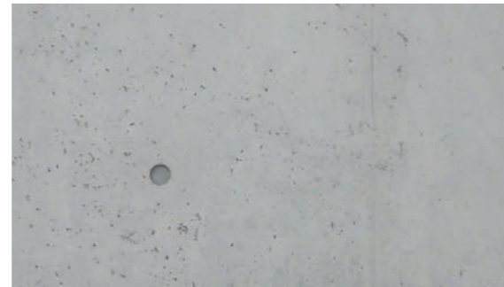
Gleichmäßige mineralische KEIM Concretal-Lasur Oberfläche © Arbeitsgemeinschaft Betonlasur
