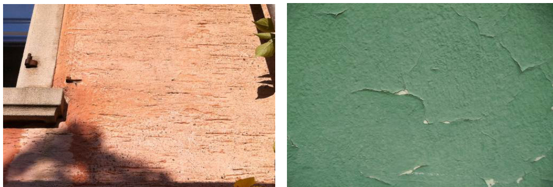
Verschiedene Alterung: Silikatfarbe verwittert, Dispersionsfarbe versprödet (rechts).
