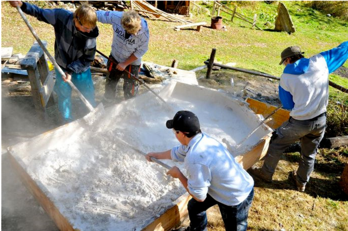
Gebannter Kalk wird gelöscht. Ein Schulprojekt der Maurerlehrlinge des Berufsbildungszentrums Bruneck. Insbesondere die Augen sind wegen der hohen Alkalität vor Spritzern zu schützen.
