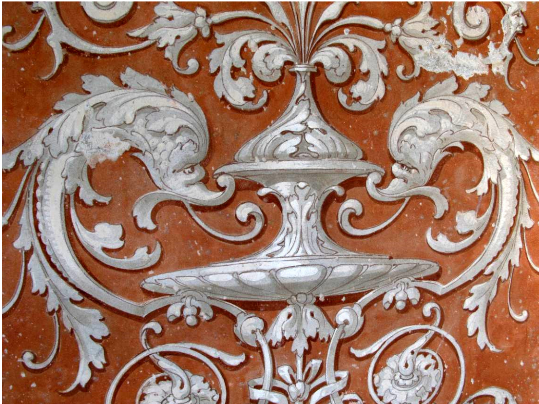
Fassadendetail Villa Patumbah in Zürich, Silikatmalerei auf Kalkputz um 1885. Hier wurde die Silikatfarbe als Lasur aufgetragen, was eine überaus plastische Wirkung erzeugt.
