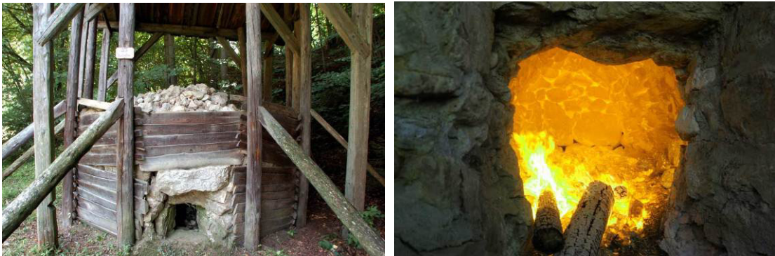
Nachgebauter historischer Kalkofen, Kalkbrand bei ca. 800 Grad Celsius
