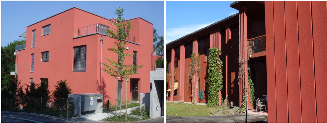
Keim'sche Kieselfarbe auf einem organischen Deckputz und auf einer Holzfassade (rechts)
