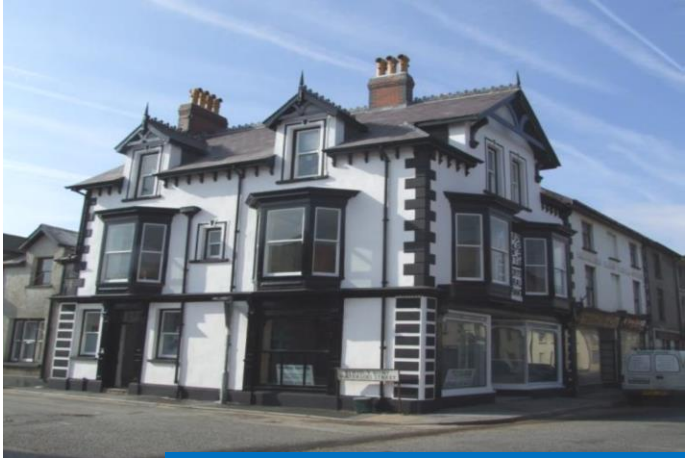
Jubilee Stores, Llandovery - KEIM Granital
